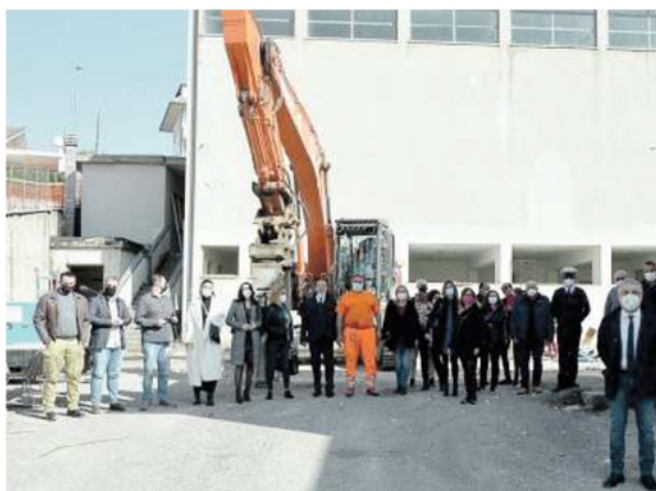
È iniziata la demolizione della vecchia scuola
