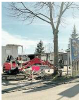
I lavori a Camerino
